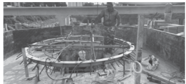
Hình 6. Lắp đặt chi tiết đặt sẵn tại công trường
