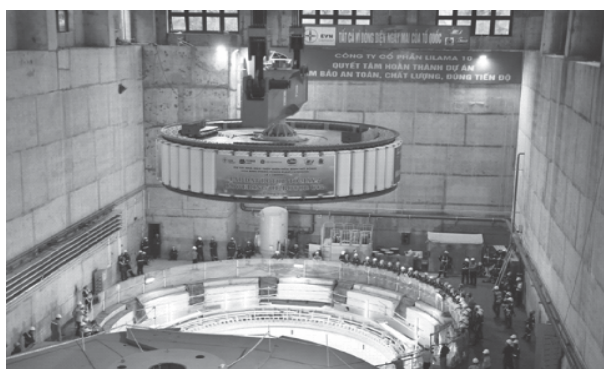
LILAMA 10 tiếp tục khẳng định vai trò chủ lực tại Dự án Nhà máy Thủy điện Hòa Bình mở rộng – công trình trọng điểm quốc gia.
